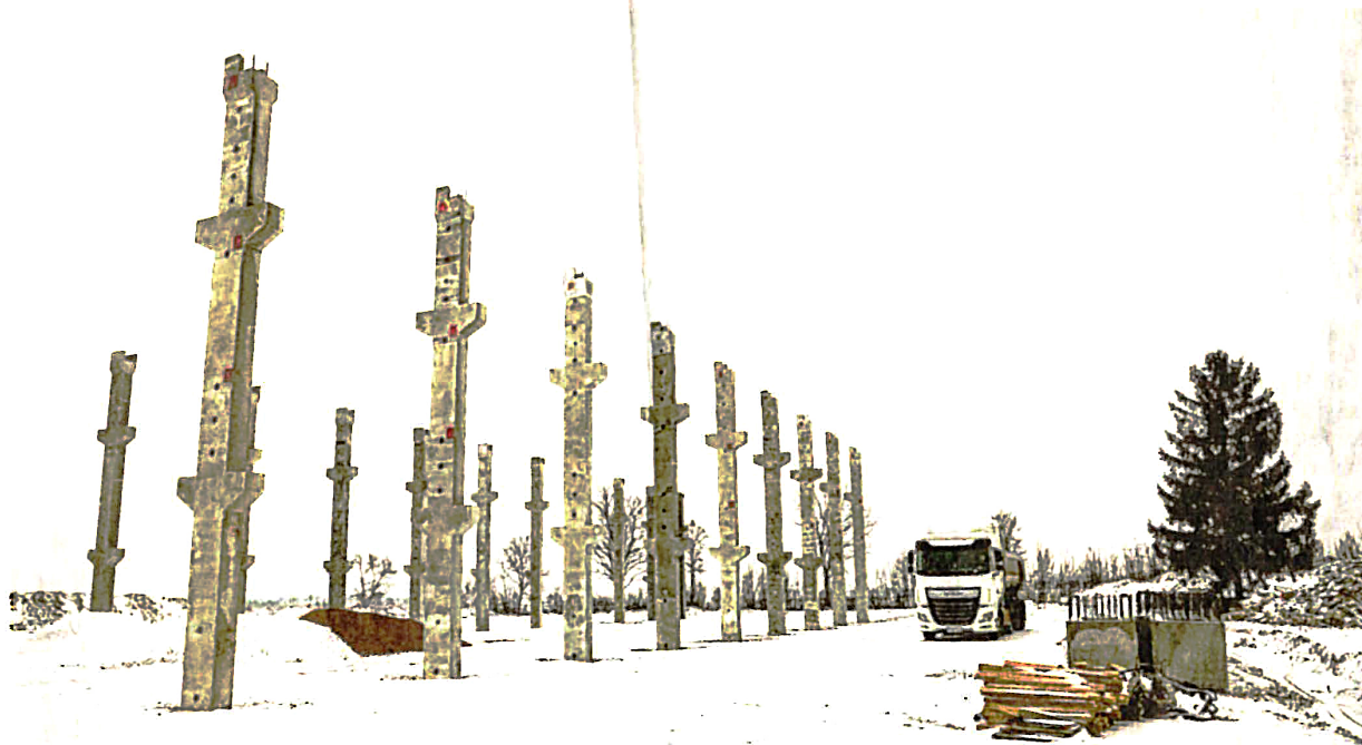
Saját gyártású vasbeton elemeket használnak fel az üzemük új gyártócsarnokának az építésekor
